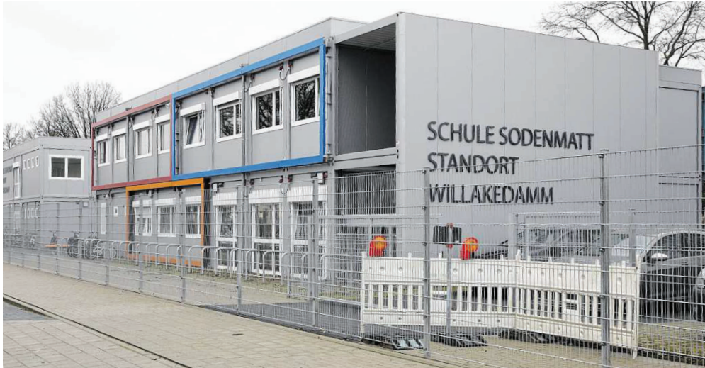
Die Grundschule Sodenmatt wurde in Huchting neu gegründet. Bisher findet der Unterricht hier im Mobilbau statt, sie soll ein neues Gebäude bekommen.
